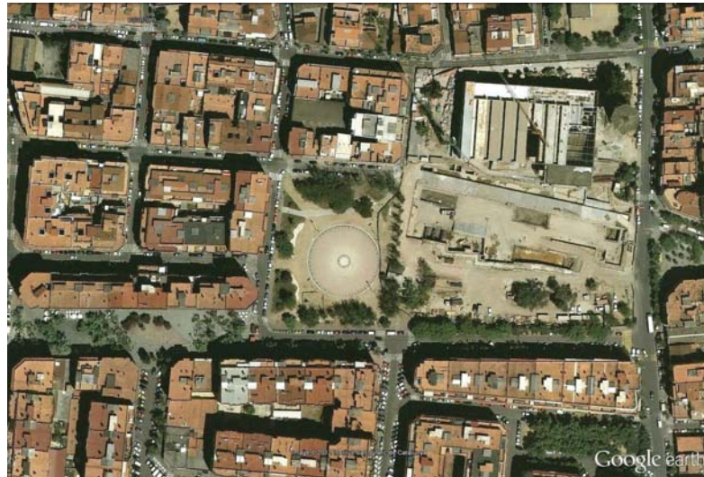
Foto aèria de la zona de la plaça de Catalunya , en la que s'aprecia la construcció del Cèntric , la Línia 9, i la traça de l'Avinguda del Canal sobre el nou col·lector.
